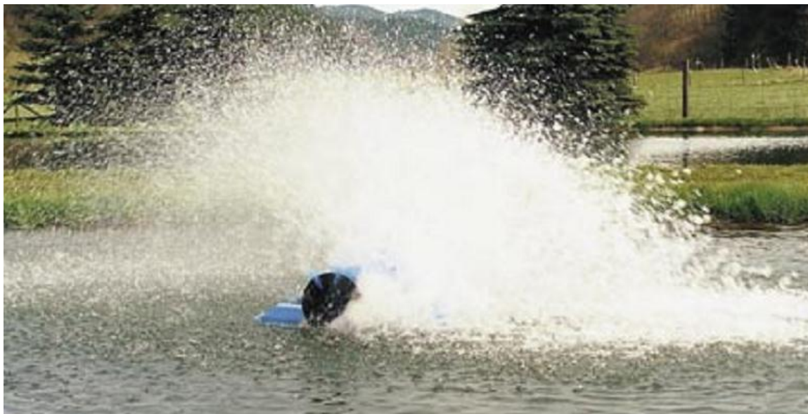
Рисунок 50 - Аэратор AQUA- Wheel в рабочем режиме
